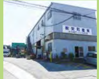
本社工場。神奈川県(綾瀬市)と静岡県に拠点を置き全10工場を有する
